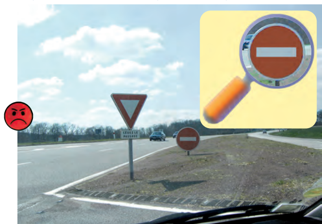
En position de conducteur, ces panneaux masquent la visibilité.
