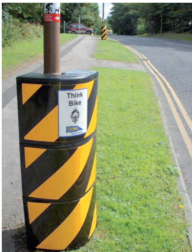
Illustration d'un support de signalisation équipé d'une coque atténuant le choc.
