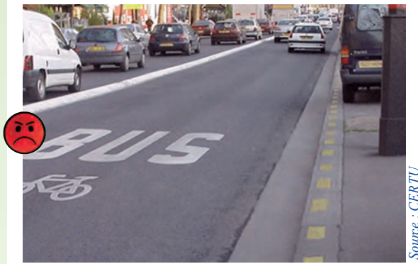
Exemple de bourrelet difficilement perceptible en raison du marquage continu.
