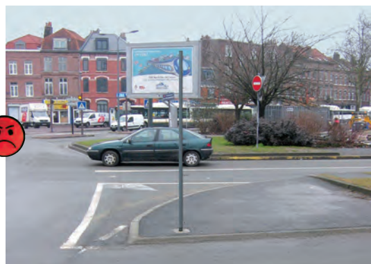
Obstacle inutile : support de panneau de signalisation non utilisé en sortie de giratoire sur trajectoire possible d'un 2RM en cas de perte de contrôle.
