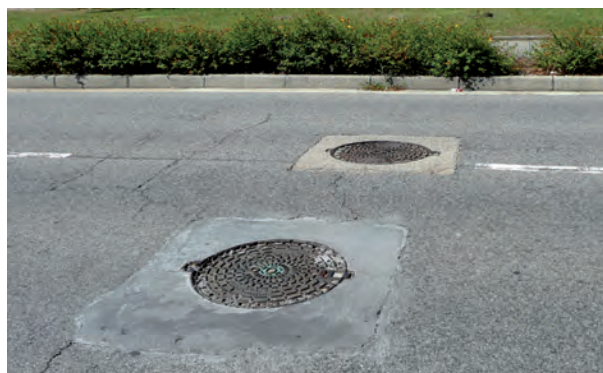
Exemple de plaque dont le scellement ne présente aucun danger pour un usager 2RM.
