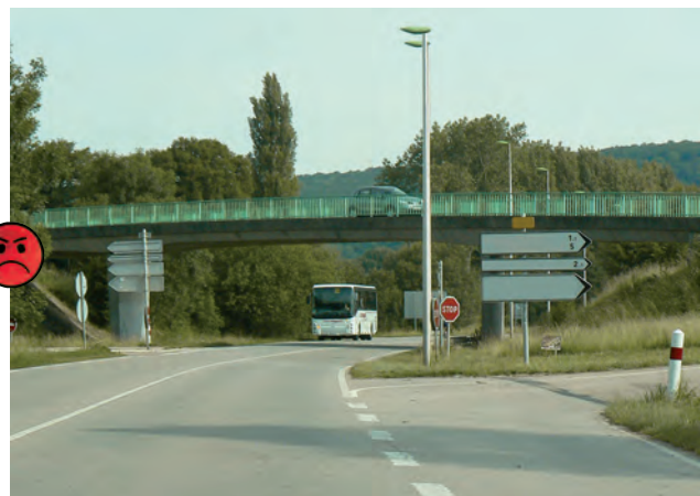
Candélabre et support de signalisation en extrémité du divergent, dans une zone de risque (décélération et courbe). Pistes de solutions :
