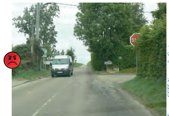
La végétation masque en partie le panneau STOP. Il est encore moins visible car placé en retrait.
