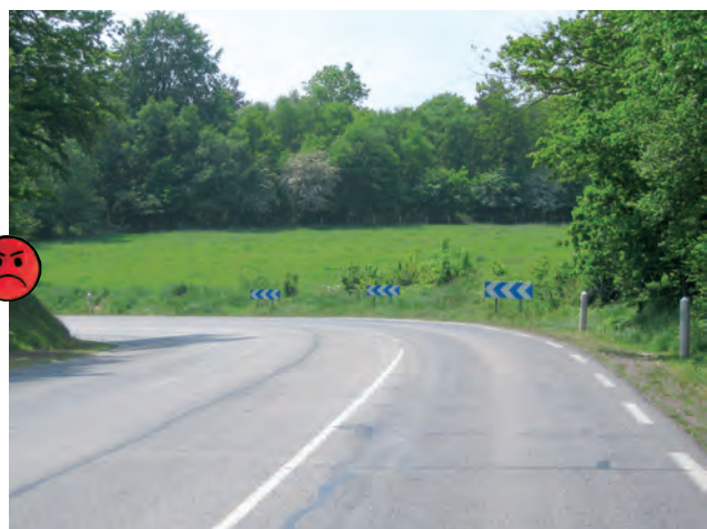
Signalisation en virage.
