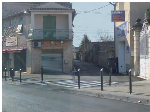
L'extrémité biseautée des potelets utilisés ici peut présenter un danger pour les usagers deux-roues motorisés.
