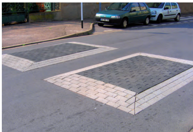
Coussin construit sur place
