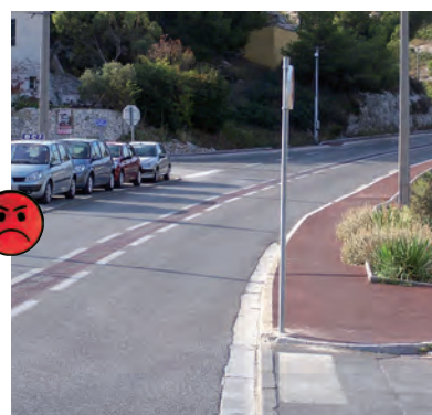
Support de panneau de signalisation trop proche de la chaussée.
