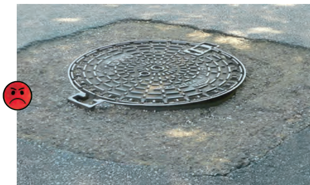
Exemple de plaque dont le scellement est en cours de détérioration.
