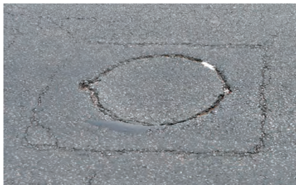
Exemple de plaque d'égout revêtue ne présentant aucun danger pour un usager 2RM.
