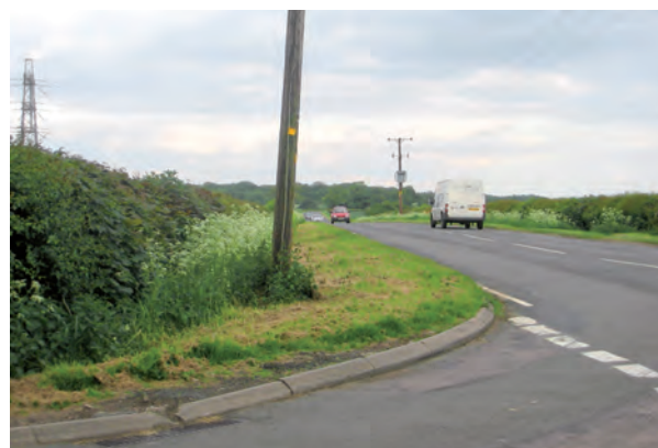
Le fauchage de sécurité régulier en intersection permet de maintenir une bonne visibilité.
