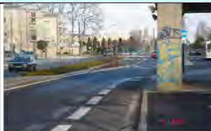
Photo Après (source Cete)
