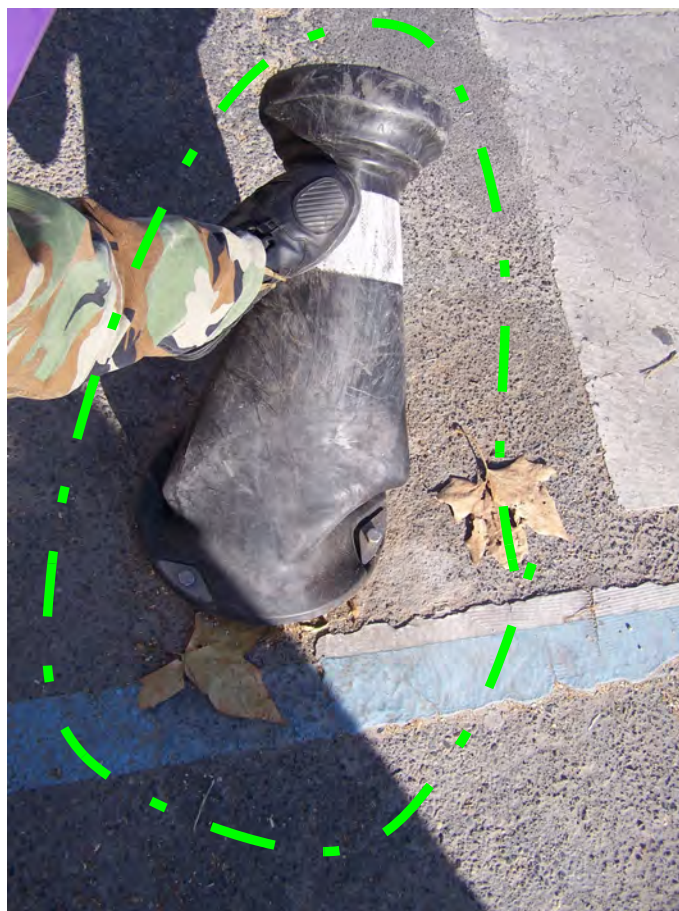
Borne anti-stationnement amovible en plastique, non agressive pour les deux-roues motorisés. Source : MPM
