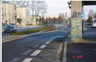
Photo Après (source Cete)
