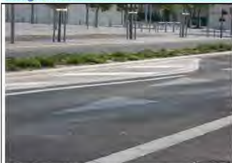
Photo (source FFMC) avant modification
