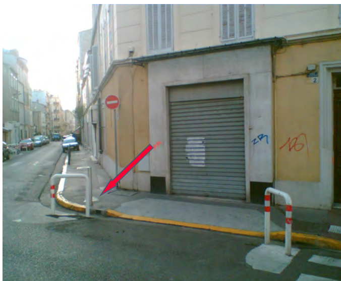
Borne anti-stationnement au bord de la chaussée – dangereux pour les deux-roues motorisés. Source : MPM
