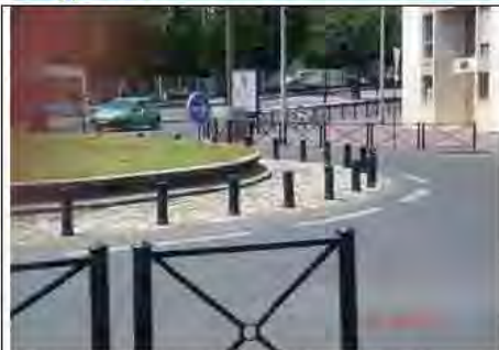
Photo de l'obstacle avant changement Source : Cete
